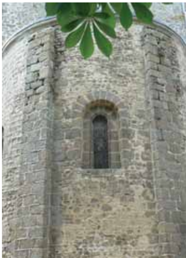
Appareillage de pierre d'époque romane (église Saint-Front de Mézangers)
