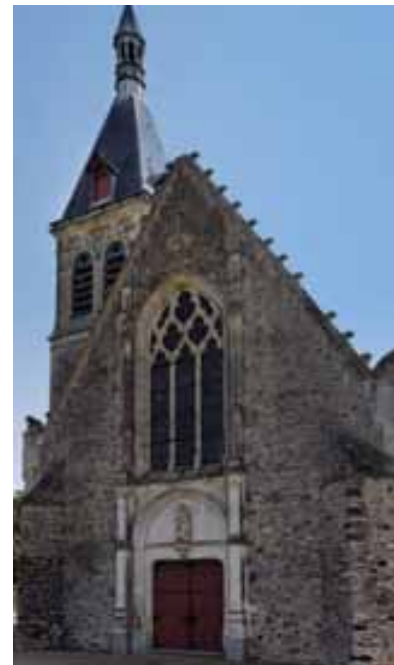
Façade principale de l'église Saint-Sixte.
