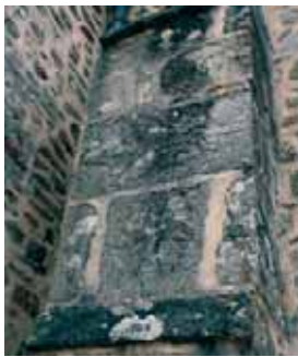
Dalles funéraires, réutilisées pour construire un des contreforts.
